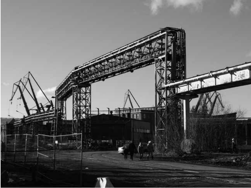
Nieistniejące już estakady przewodów rurowych; fot. W. Affelt, 2012
