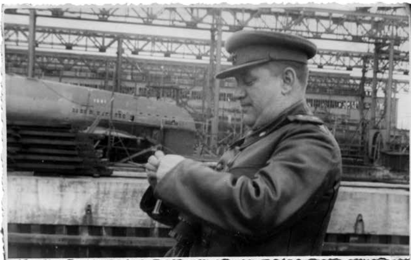
Stocznia Schichaua po zajęciu Gdańska przez Armię Czerwoną, w tle widoczna pochylnia, na której odbywał się montaż U-Boota typu XXI. Gdańsk, 1945 r. Fot. ze zbiorów MIIWS
