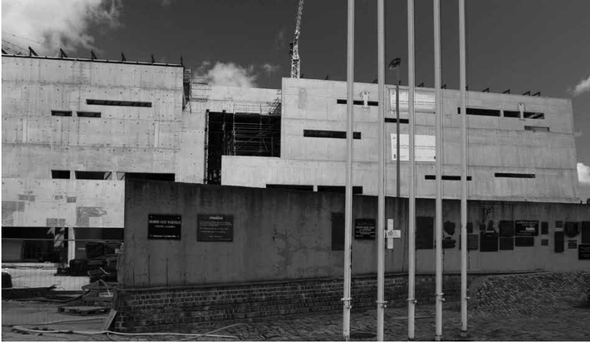
Gmach ECS-u w trakcie budowy. Na pierwszym planie fragment muru epitafijnego pomnika Poległych Stoczniovcow 1970; fot. M. Targowski
