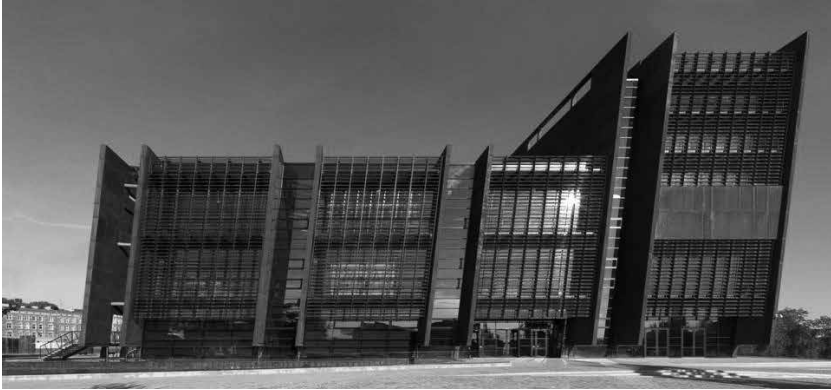
Fasada gmachu ECS-u od strony Drogi do Wolności; fot. W. Kryński
