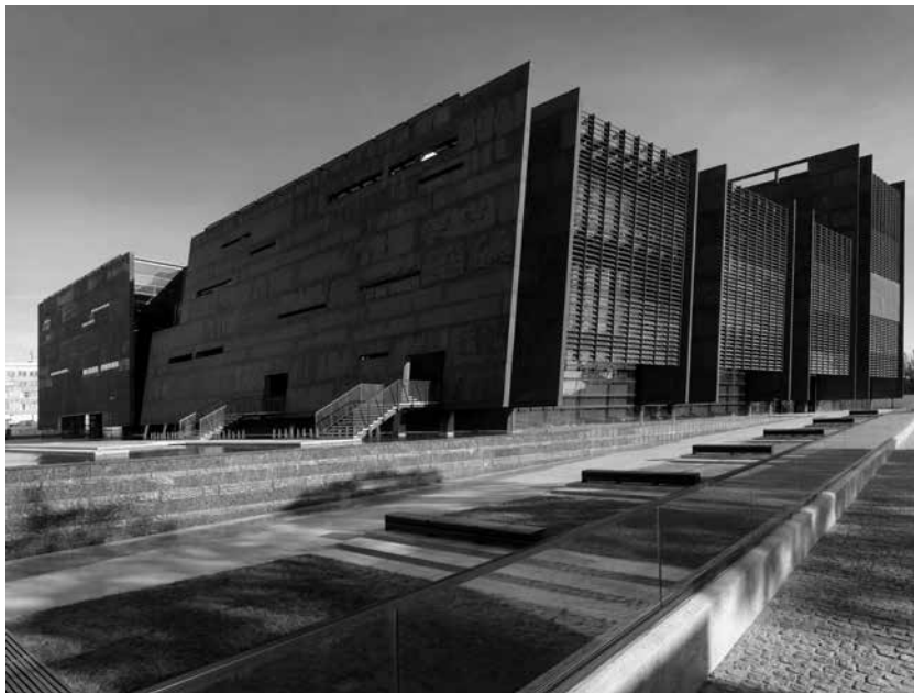
Rytm pochyłych ścian fasady wschodniej; fot. W. Kryński
