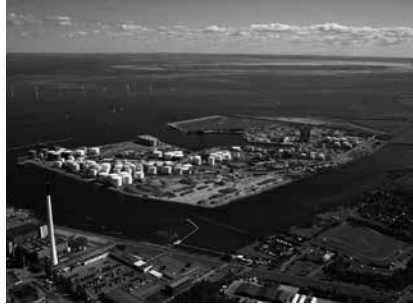
Terminal paliwowy w Rønne
