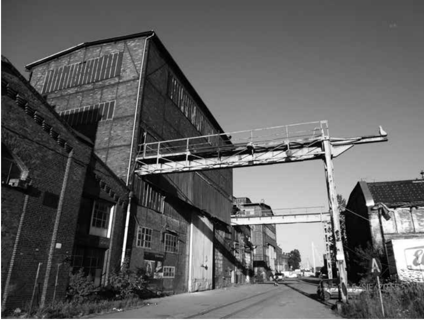
Teren „A”, hala z zewnętrzną suwnicą belkową; fot. W. Affelt, 2015
