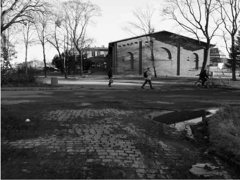
Widok na ul. Doki, Droga do Wolności w pobliżu Sali BHP; fot. W. Affelt, 2012
