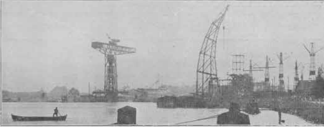
250-tonowy dźwig stały i 100-tonowy dźwig pływający
