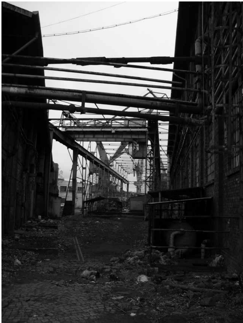
Postępująca degradacja, stan z 2005 r. – w głębi jedna ze stoczniowych suwnic, inna, miejsce pracy Anny Walentynowicz, szczęśliwie ocalała jako eksponat wystawy stałej ECS-u; fot. M. Targowski
